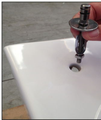
02 Inserire fissaggio nel foro del WC. Insert the screw in the appropriate hole.
