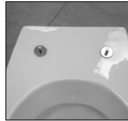
04 Fissaggi inseriti. Inserted fixing screws.
